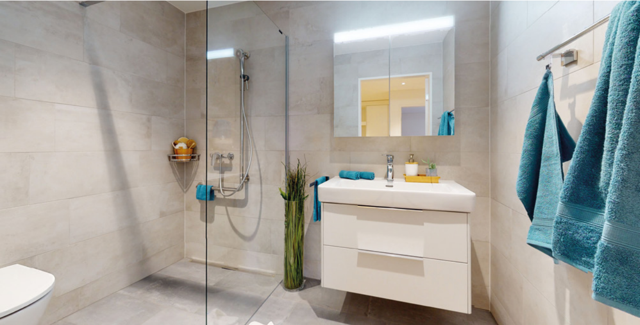
Rollstuhlgängige, rutschfeste Bäder mit Spezialarmaturen und abnehmbarer Duschverglasung.
