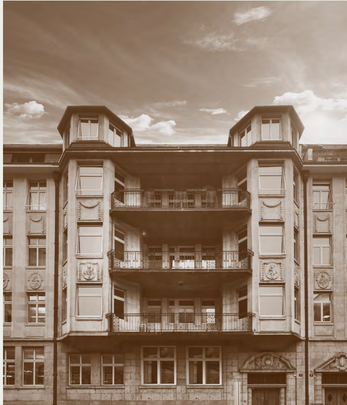
Aussenfassade der Liegenschaft Tödistrasse 7, vor der Sanierung
