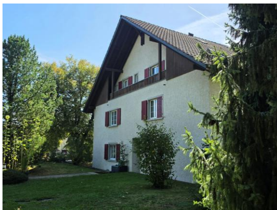
Ansicht von Norden mit Hauseingang
