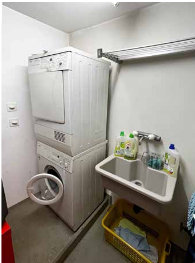
Torre di lavaggio
