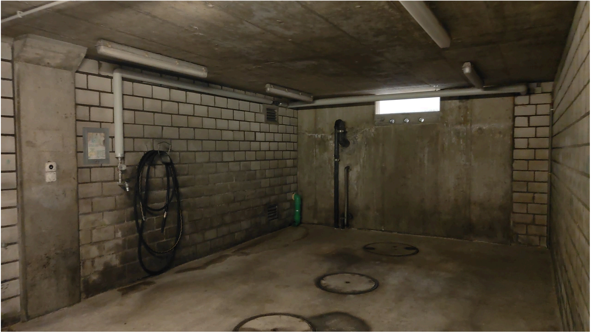
Waschplatz in der Einstellhalle
