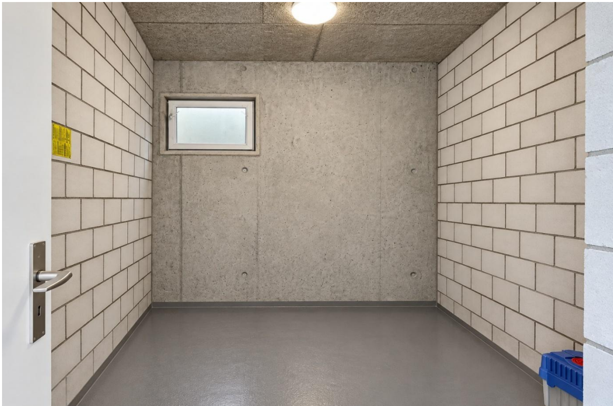
Der separate Kellerraum mit vielseitigen Nutzungsmöglichkeiten und zusätzlichem Stauraum.
