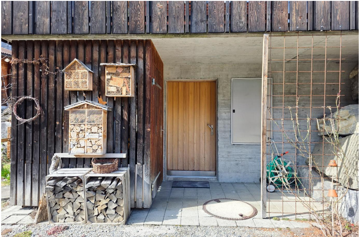
Der Zugang in den Kellerraum mit dem Geräteschuppen
