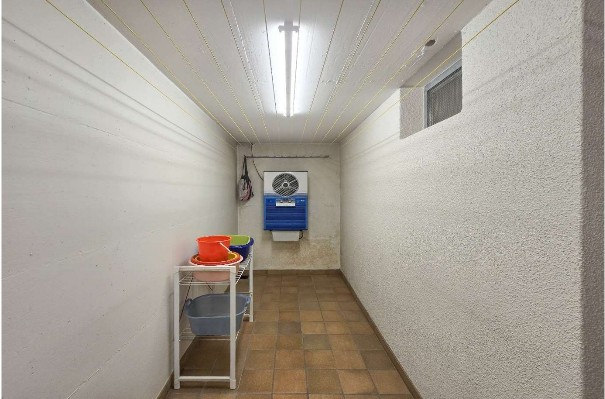
Der Trocknerraum mit Secomat
