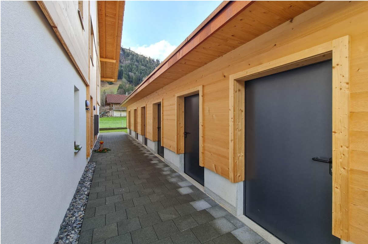
Der Nebenraum mit Licht und Stromanschluss... MUSTERFOTO
