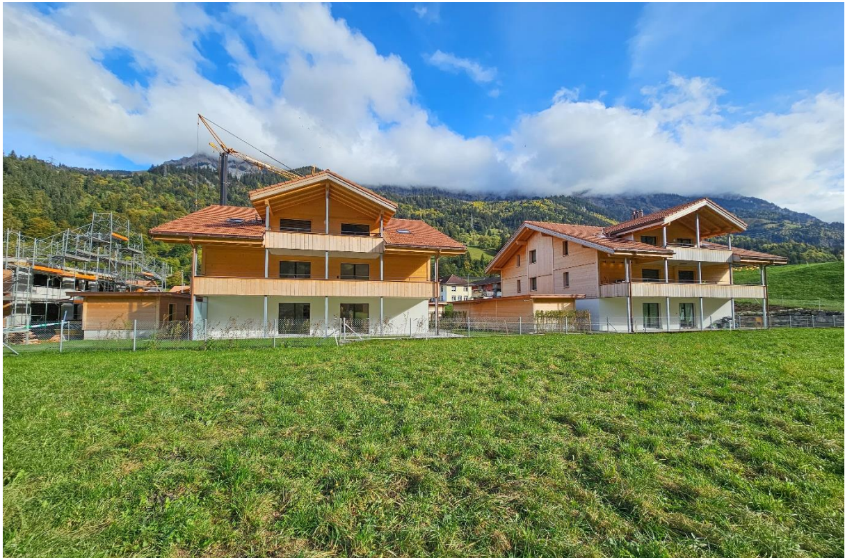
Das Haus Gehrihorn ist das Vierte von 4 Mehrfamilienhäusern
