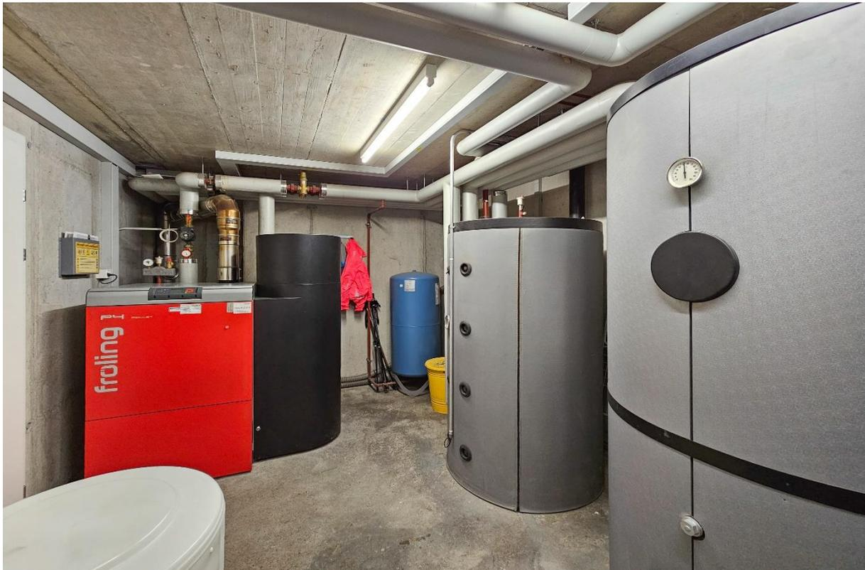
Hier sind die Installationen der Pelletsheizung, Wärmeverteilung über Fussbodenheizung, Warmwasseraufbereitung über Solar, Lüftungsanlage, Elektrotablar und Wasserenthärtungsanlage anzutreffen
