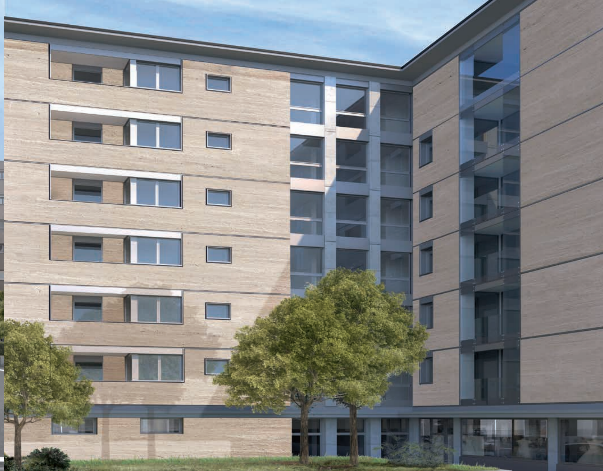
Vista da Corte Interno
