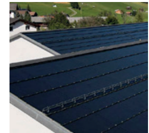
Steildach / PV-Anlage Photovoltaik-Indachanlage mit Blindmodul
