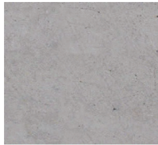
Boden Zementüberzug gestrichen
