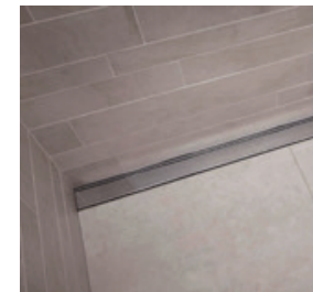
Dusche Boden Feinsteinzeug im Gefälle mit integrierter Rinne z.B. Typ Cleanline Fa. Geberit Duschtrennwände in Klarglas
