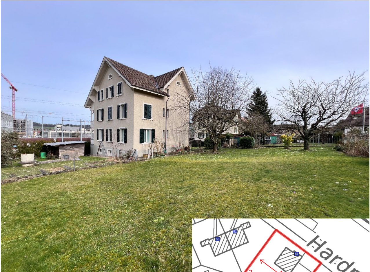
Blick von der Westecke nach Ost (3)
