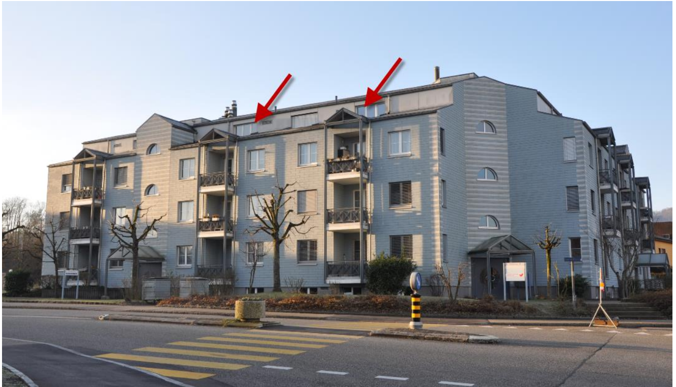
Mehrfamilienhaus von Nordosten
