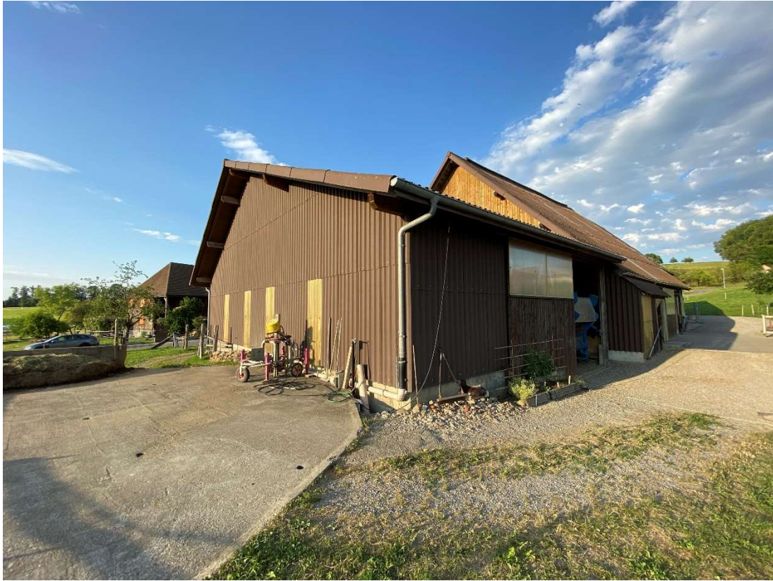
Ansicht Südwest Zufahrt zwischen Remise und Jauchegrube möglich
