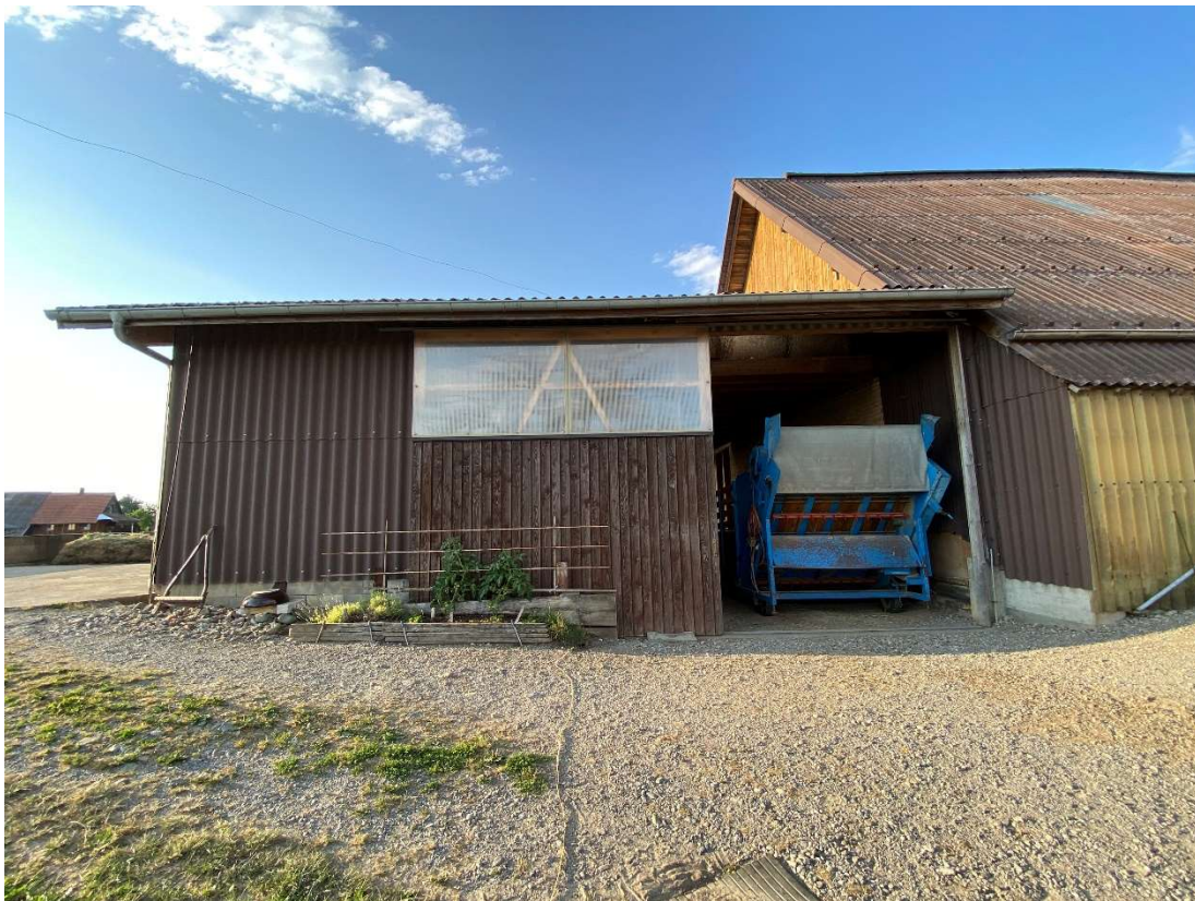
Ansicht Süd Remise (durchfahrt möglich)
