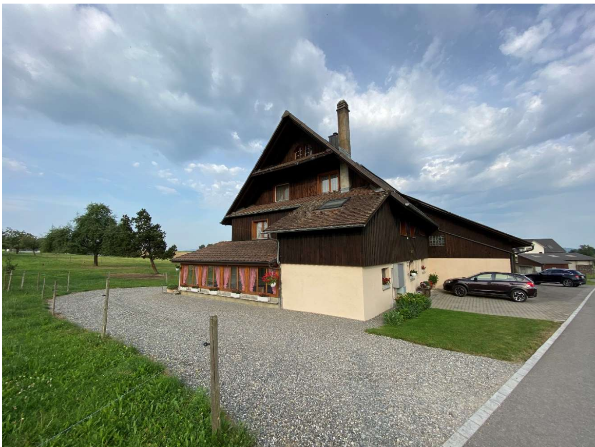
Ansicht Osten Zufahrt Heizungsgebäude
