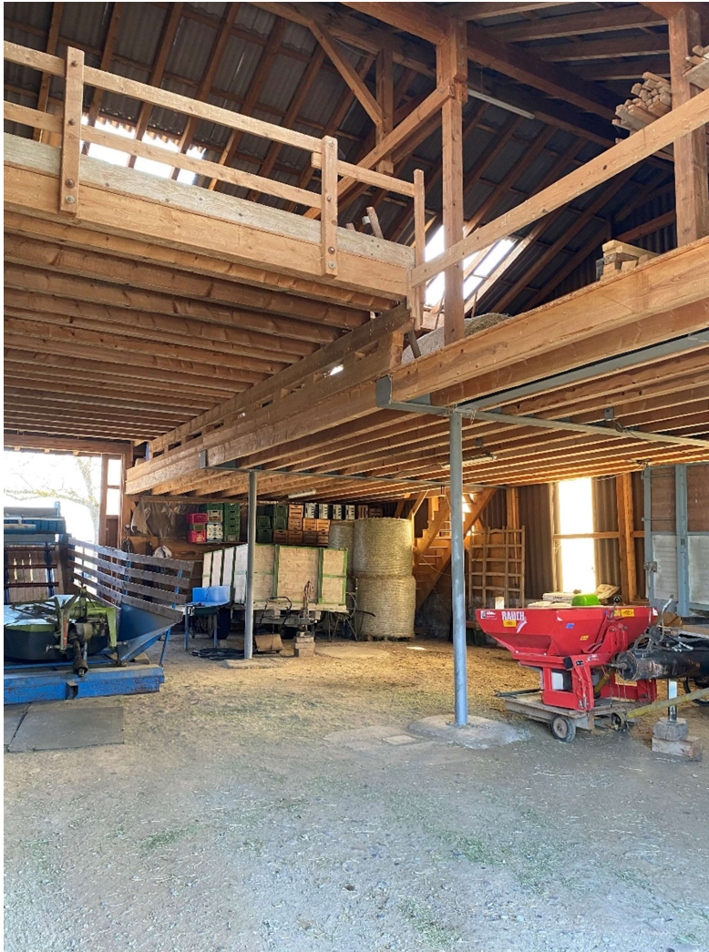
Remise Maschinenhalle Konstruktion
