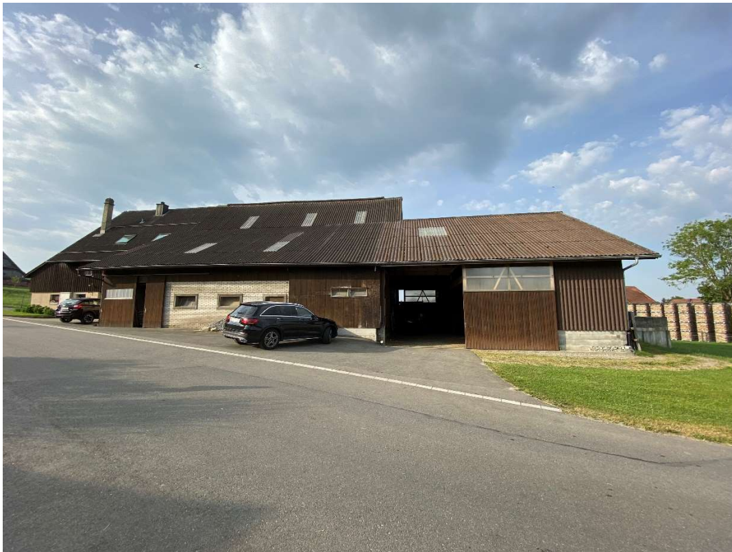
Ansicht Nord Zufahrt Hinterdorfstrasse (Nebenstrasse)
