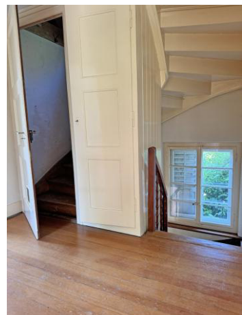
Treppenaufgang | Flur im OG mit Einbauschränk
