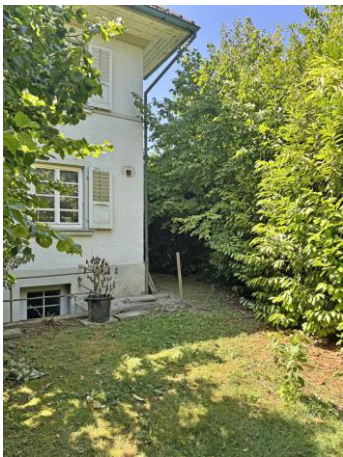
hinter dem Haus - Aussenkellertreppe
