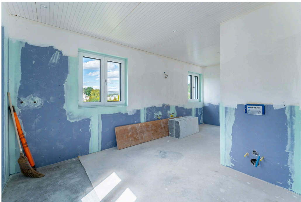
Rohbau Badezimmer OG
