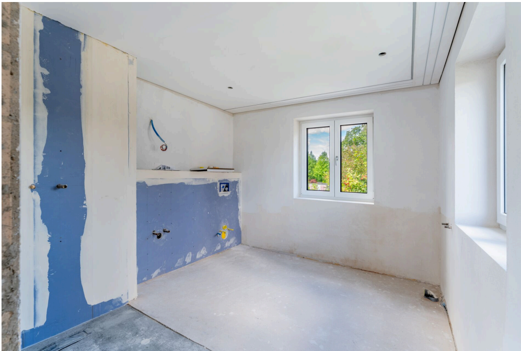
Rohbau Dusche EG
