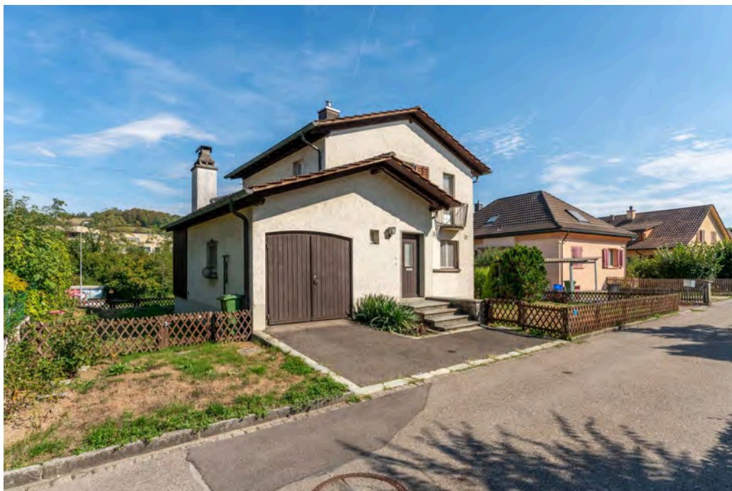
Westfassade mit Garage
