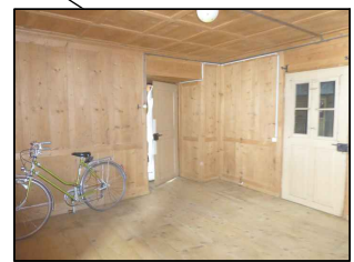
06_Zimmer Wand und Deckentäfer ist vorhanden und soll neu montiert werden.
