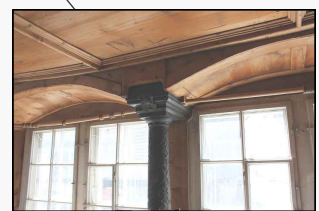
02_Wohnen Detail Fenstersäule mit Familienwappen der Bauherrschaft und Baujahr 1624 Wandtäfer und Fensterpartie mit abgestützten Stichbogen beibehalten.
