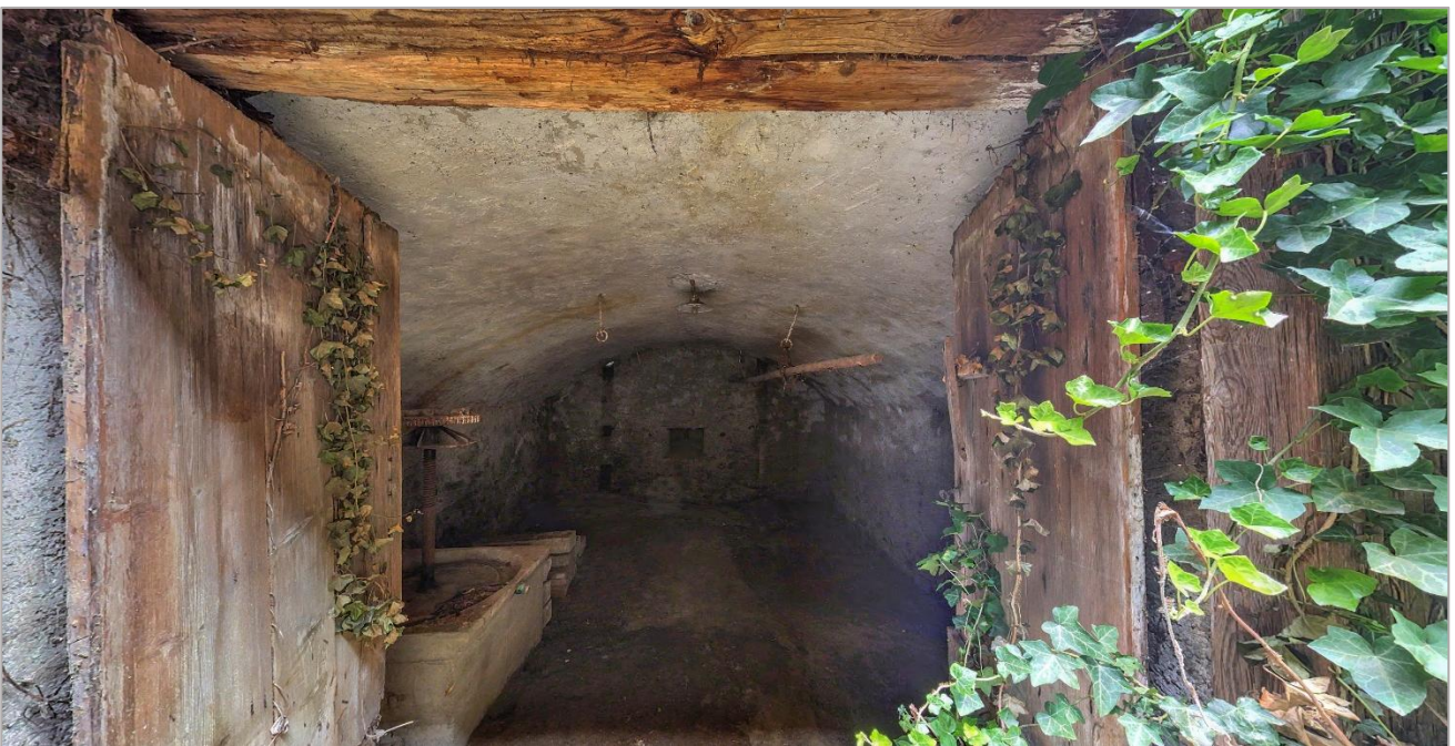
Blick in den alten Gewölbekeller
