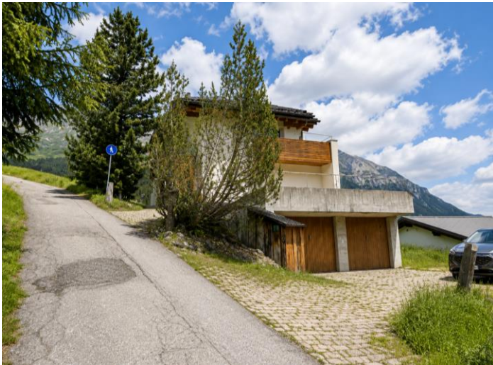
Ansicht von Westen – Zufahrt zur Garage
