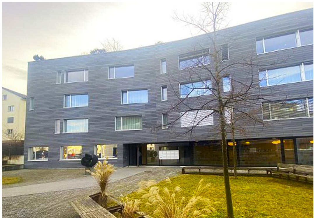
Ansicht von Norden (NO-Fassade vom Hof zwischen den beiden Häusern)
