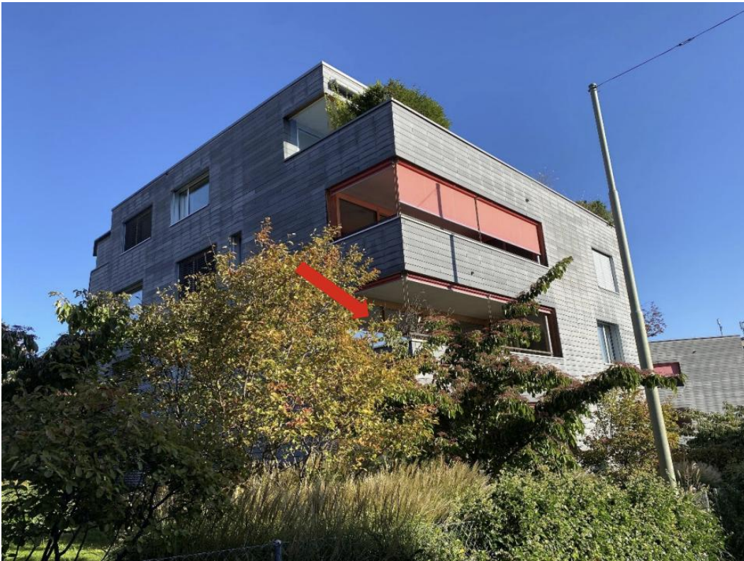
Ansicht von Süden (SW- und SO-Fassade von der Römerstrasse aus)
