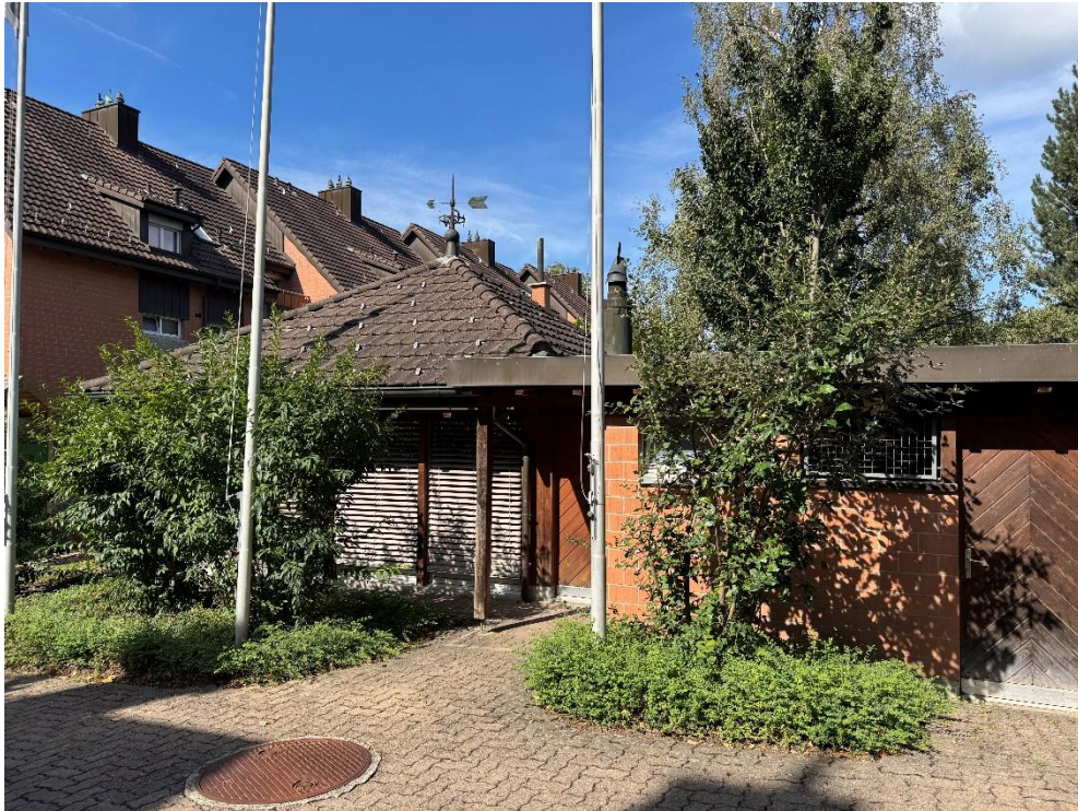
Gemeinschaftlicher Pavillon mit Spielplatz innerhalb der Überbauung
