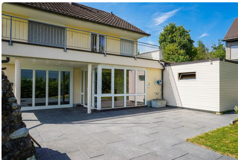
überdachter Sitzplatz EG und Gartenzugang
