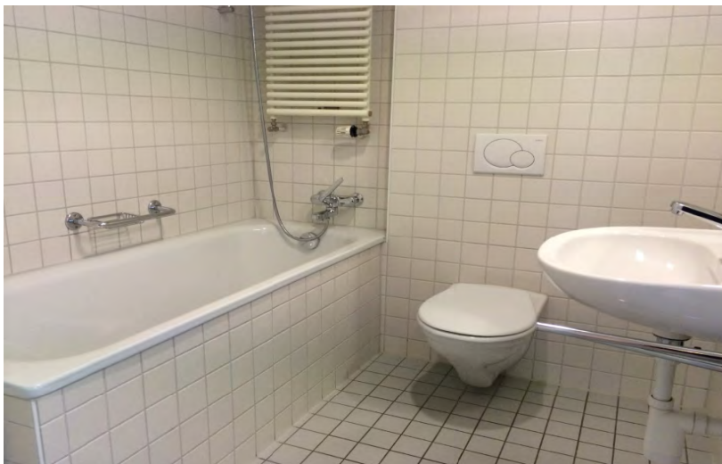
Belpstrasse 18: 4-ZW 5. OG
