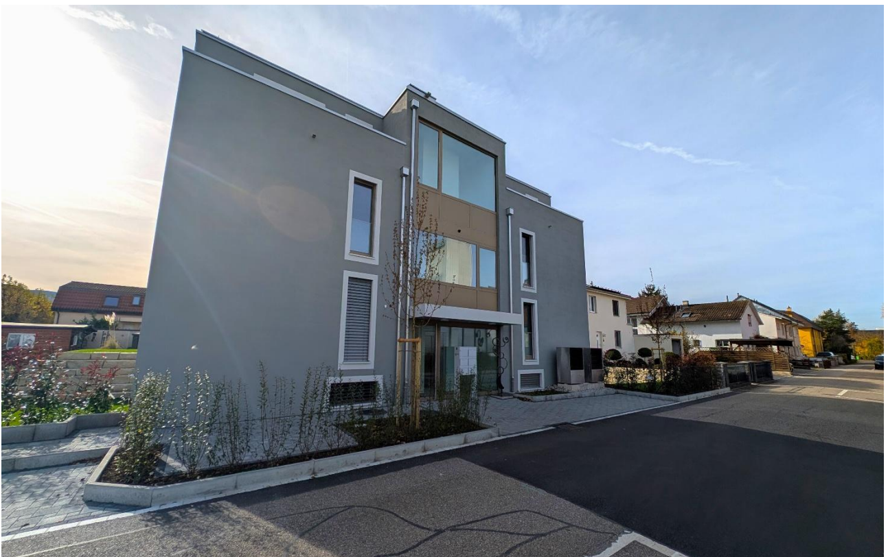
Aussenansicht 2: Nordfassade mit Hauseingang
