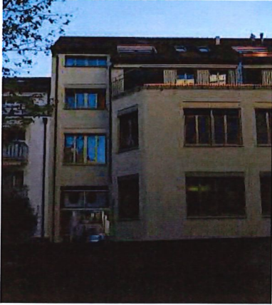
Lage Dachwohnung 32 (West- / Hofseite)
