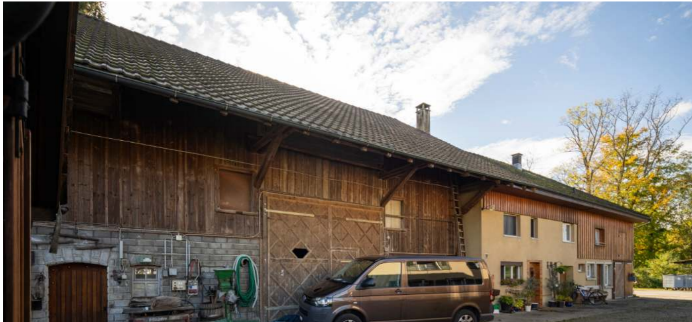
Ansicht Stall und Wohnhaus
