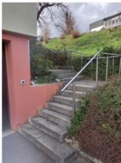
Treppenaufgänge hinter (links) und vor (rechts) des Hauses
