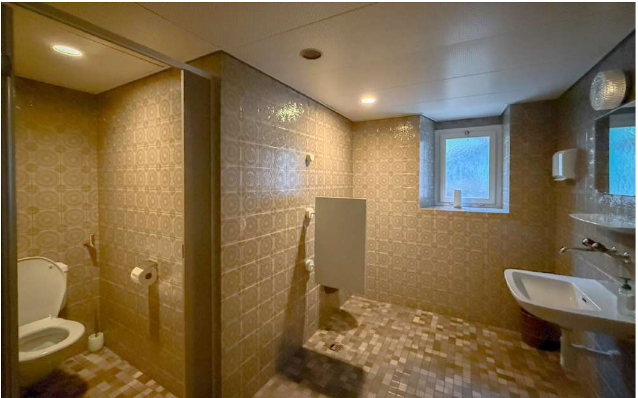
EG Restaurant WC Anlagen
