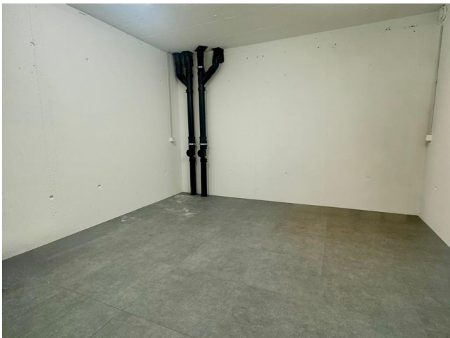
Eigener Kellerraum von 20 m 2
