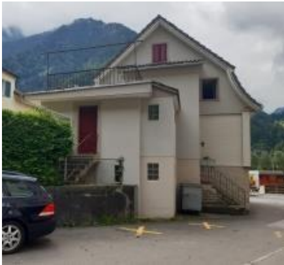
Heizung Vor vielen Jahren Rückansicht Schwyzerstübli
