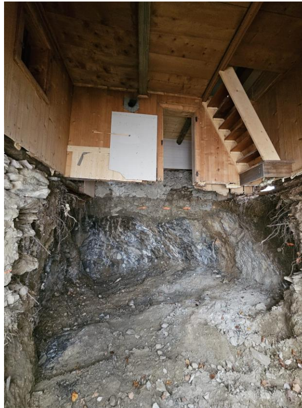
Schon ausgegraben unter den Maisensäss
