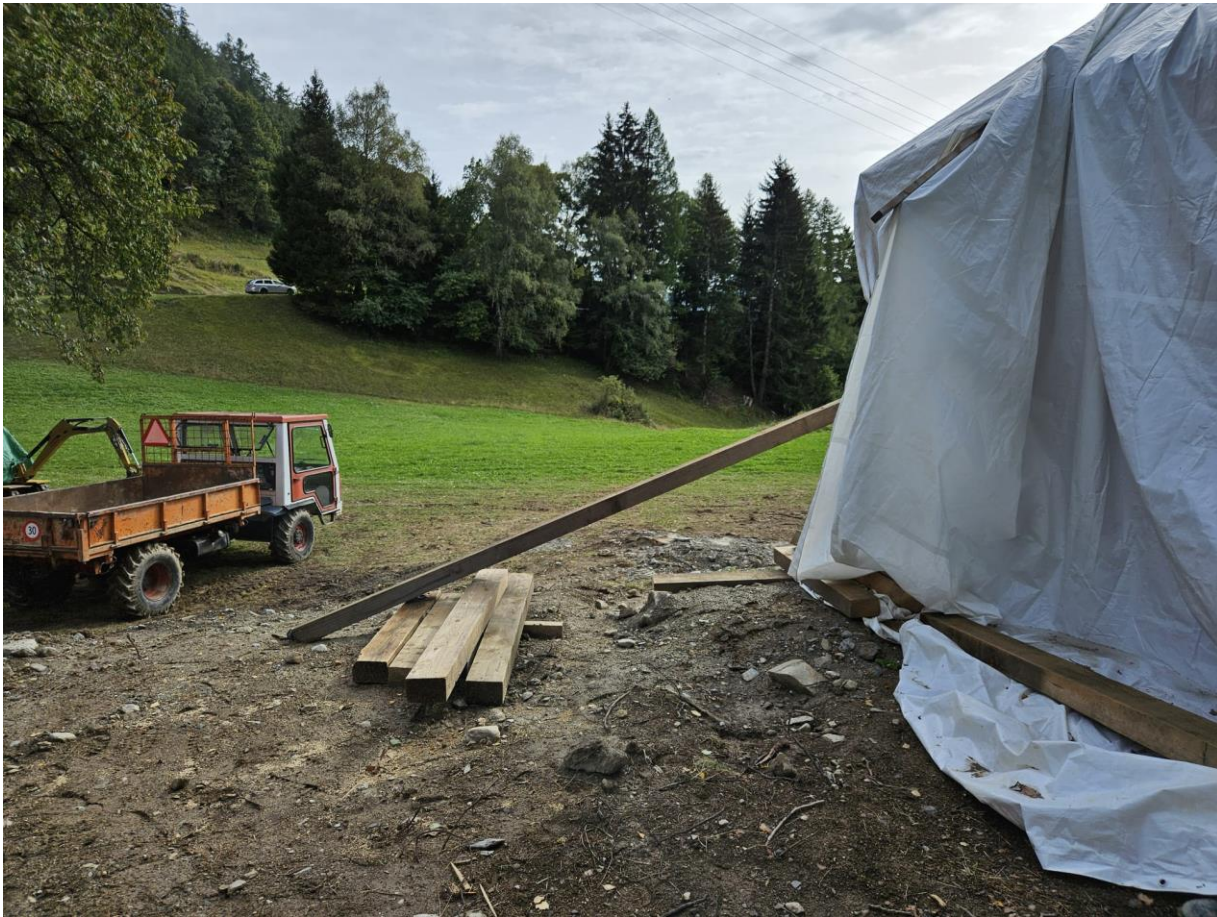
Stand der Arbeiten · Bereits ausgeführte Aushubarbeiten
