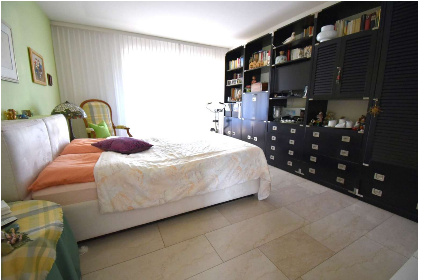
Grosses Schlafzimmer mit Wandlüfter «Aeropac»
