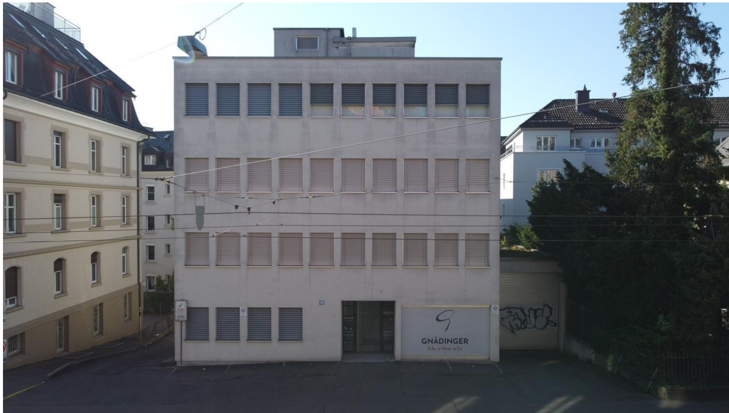
Bestandesliegenschaft Weinbergstrasse 149 – Ansicht Weinbergstrasse (Ost)
