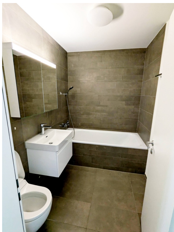
Nasszelle mit Badewanne und Geberit Dusch-WC
