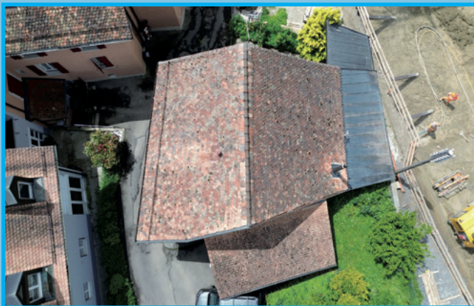
Vue de dessus avec les différentes toitures.
