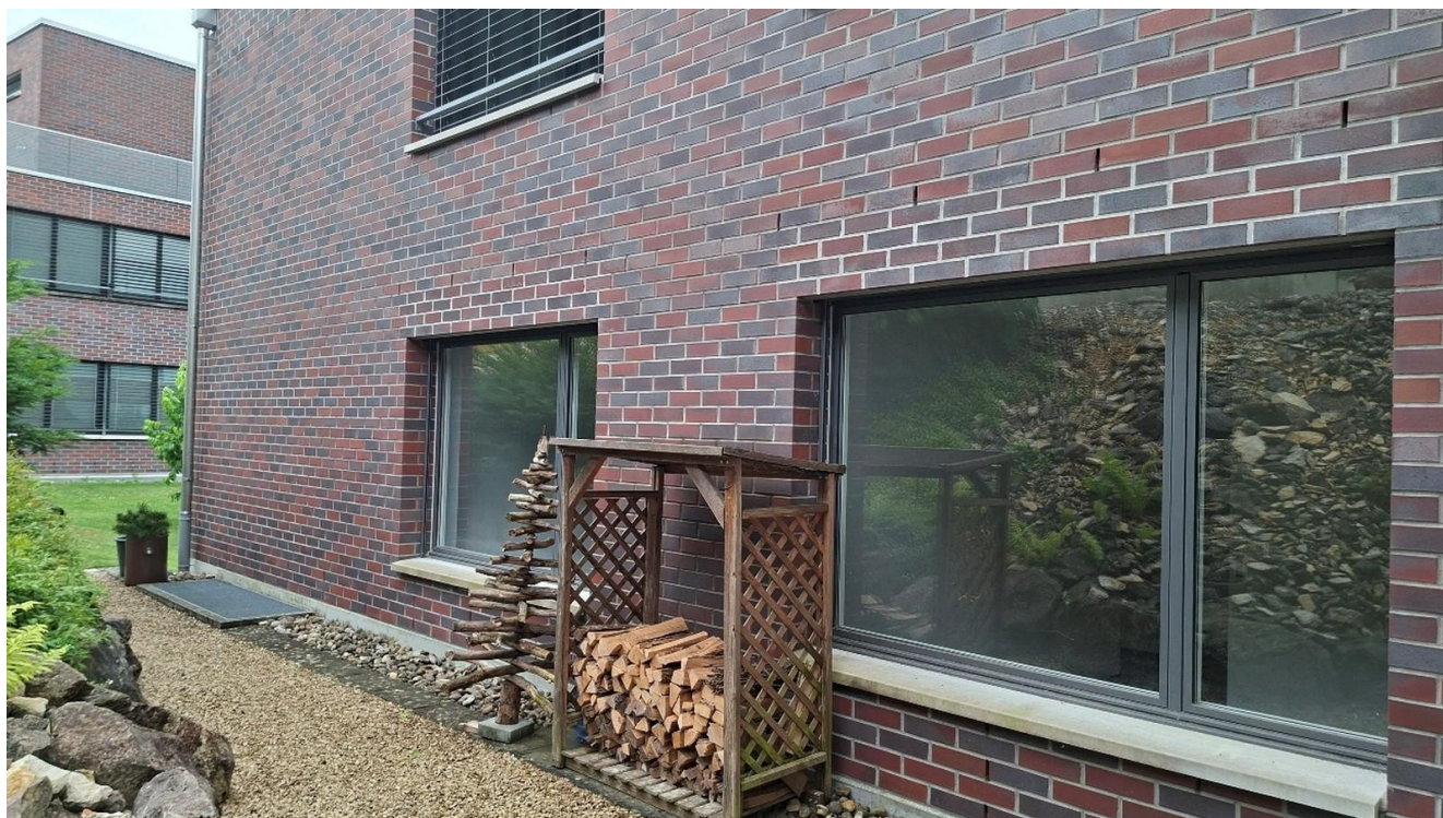
Seitlicher Aussenbereich mit Zugang
