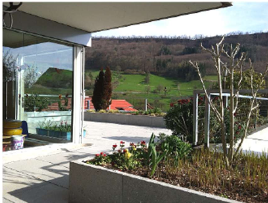
Zustand Rohbau / Fassade, Fenster Terrasse mit Sicht auf Lägerhang
