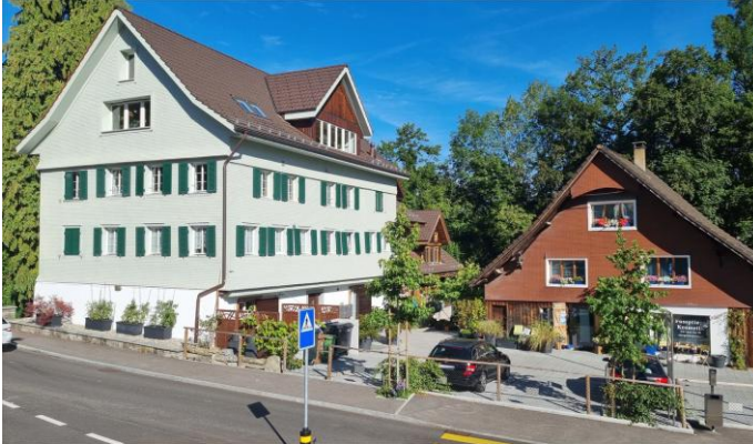
Ansicht von Osten: Bushaltestelle vorne rechts
