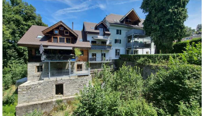
Ansicht von Südwest: Ensemble mit 3 Gebäuden
