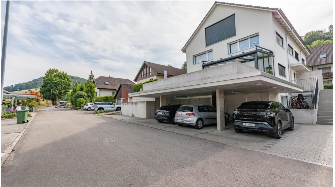
Carport / Unterstand mit 2 Parkplätzen
