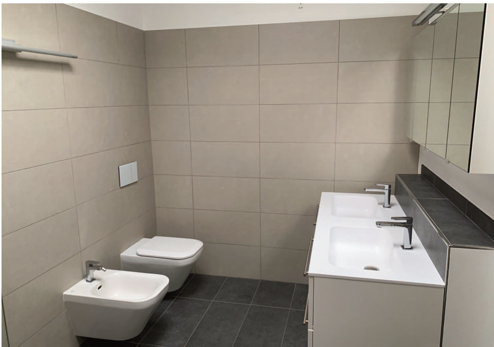
Bagno, veduta parziale.
