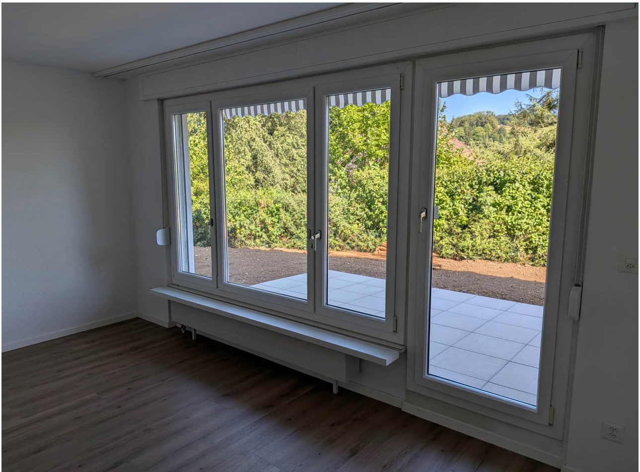
Zugang zu Terrasse von Wohnzimmer
