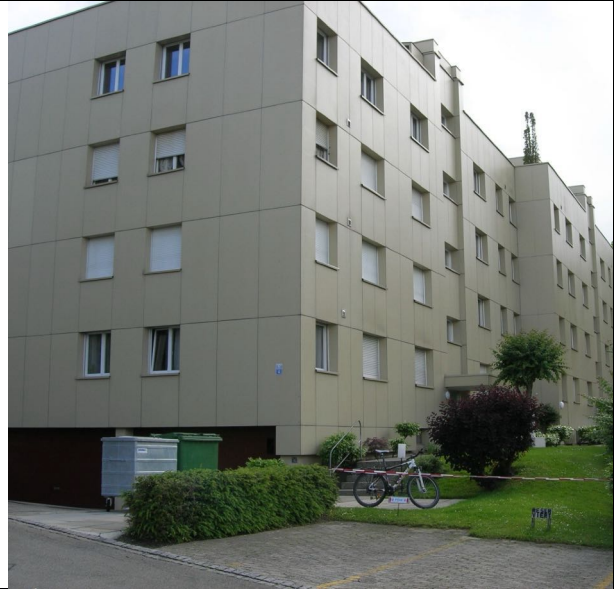
Haus Ost und Nordseite
