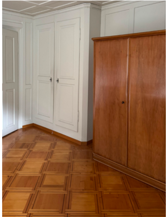
Schlafzimmer mit Einbauschränk und Kassettenboden
