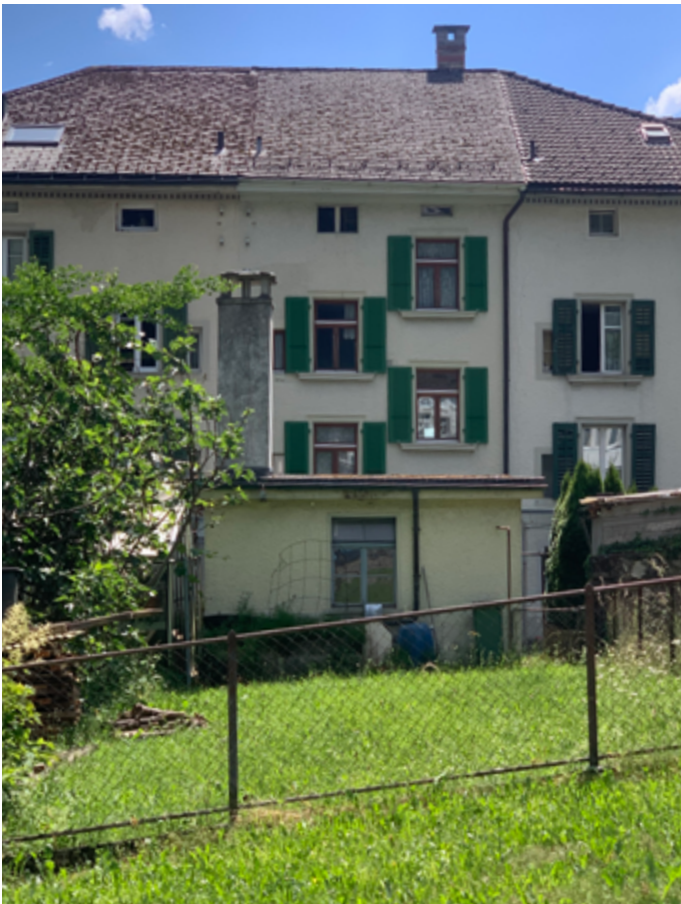
Fassade Richtung Norden und Waschhaus
