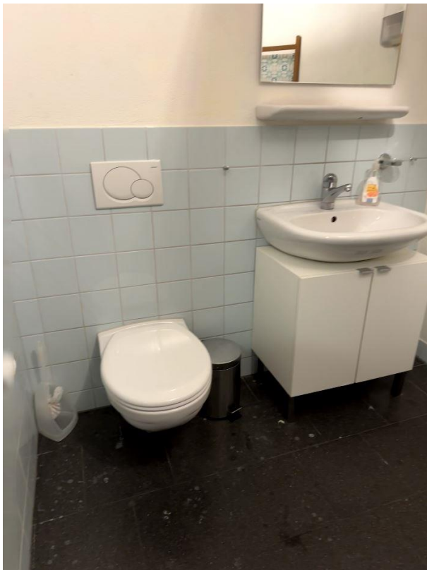
Toilettenanlage mit Waschgelegenheit
