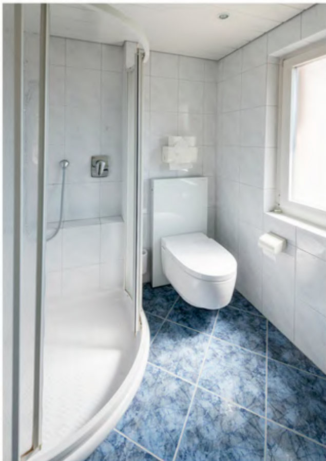
Obergeschoss: Dusche, WC, Waschtisch
