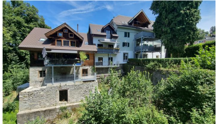
Ansicht von Südwest: Ensemble mit 3 Gebäuden
