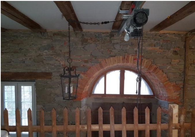
UG Mühle, Eingang. Wände sandgestraht
