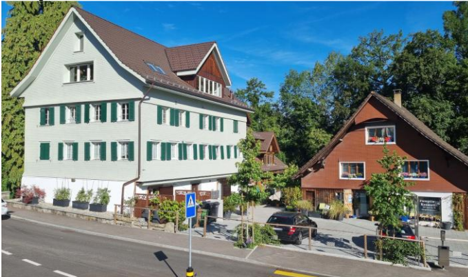
Ansicht von Osten: Bushaltestelle vorne rechts
