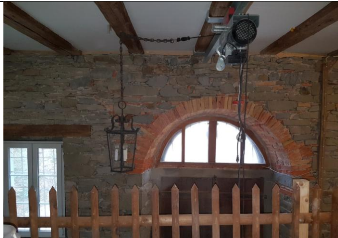
UG Mühle, Eingang. Wände sandgestrahlt
