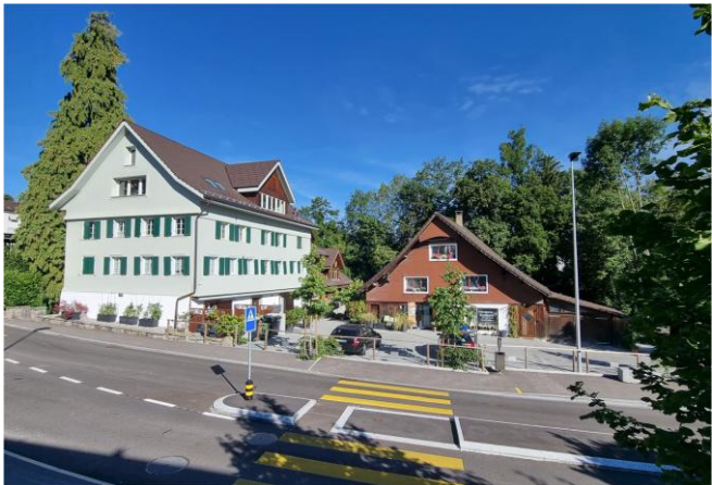
Ansicht von Bushaltestelle
