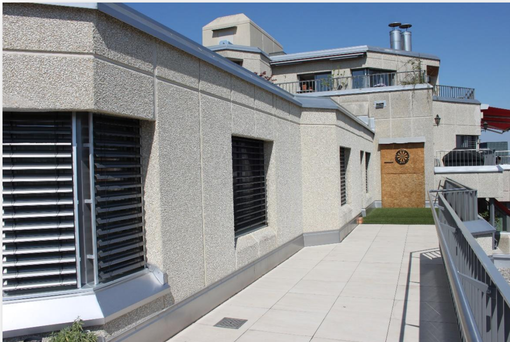
Foto 19: Terrasse, Bereich Ost
